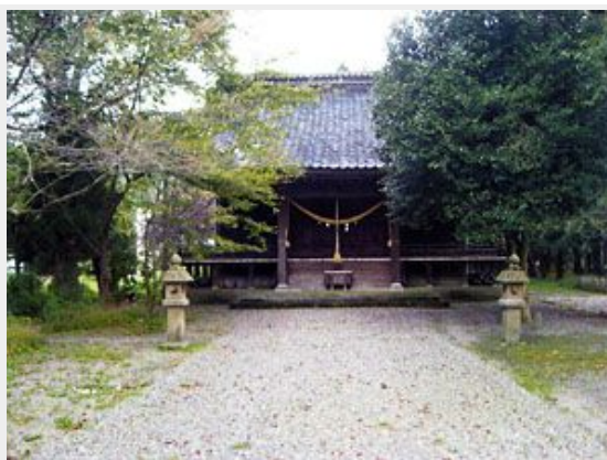
老朽化で雨漏りが深刻化している清河神社。地元住民が実行委員会をつくり、改修を計画している＝庄内町清川
